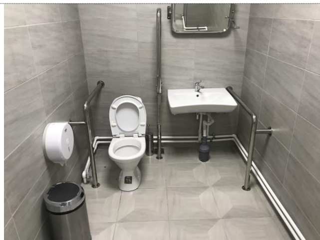
Фото №30 – Санитарно-гигиенические помещения
