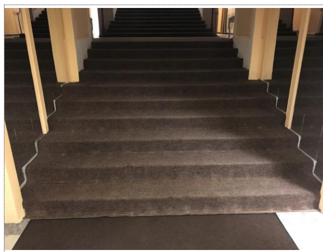
Фото №10 – Пути движения внутри здания (лестницы)
