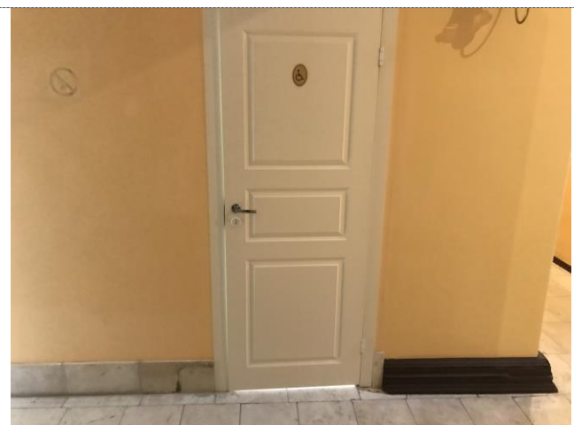
Фото №27 – Санитарно-гигиенические помещения
